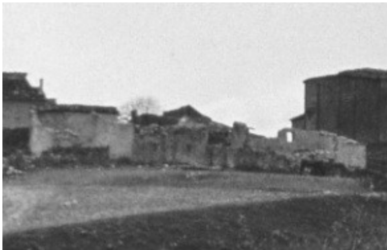
Polígono 2 visto desde el lavadero
