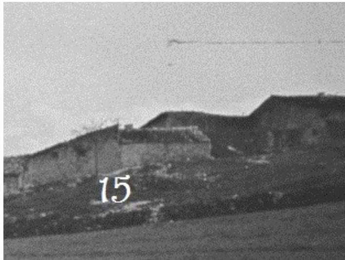
Vista desde el lavadero
