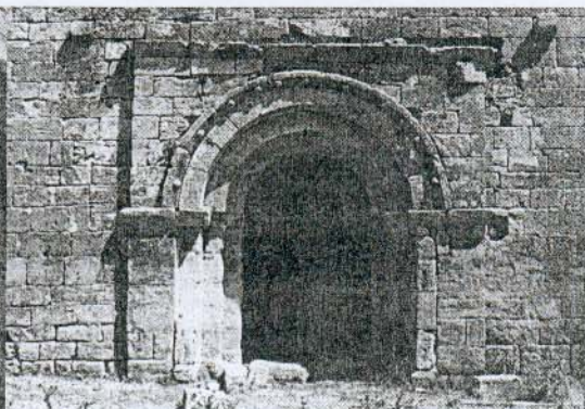
Portada de la Iglesia de Villaescusa antes del inicio de su ruina.
